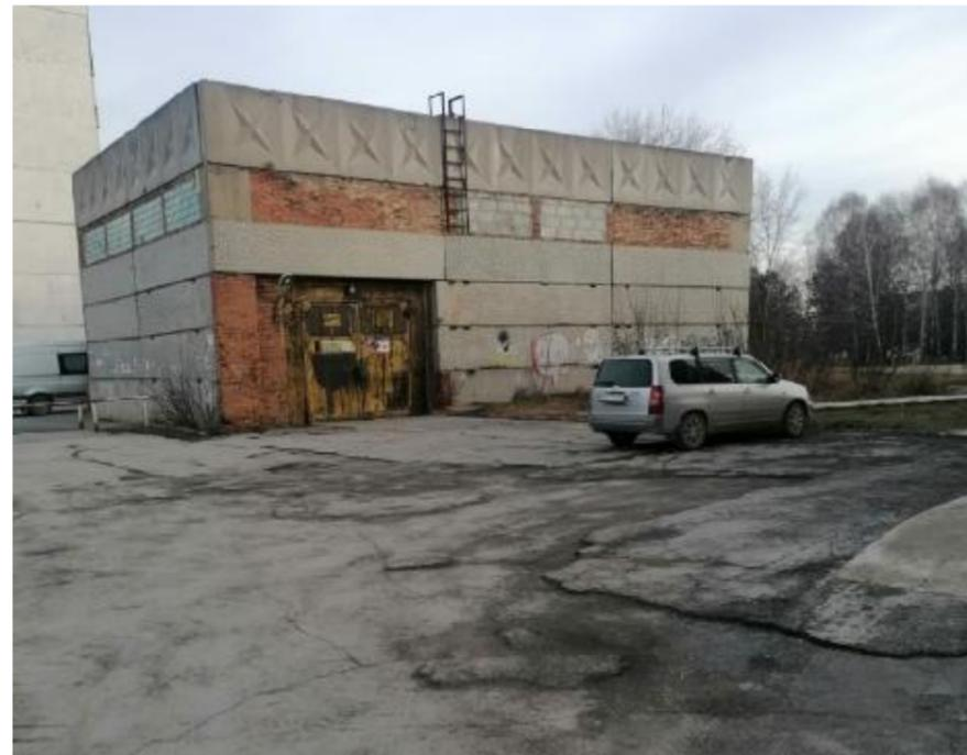
Разворотная площадка - разрушено а/б покрытие (имеются трещины, разрывы, разрушение, оголен нижний слой а/б)
