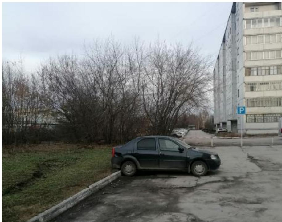
Разворотная площадка - разрушено а/б покрытие (имеются трещины, разрывы, разрушение, оголен нижний слой а/б, проседания). На данном участке из за не правильного продольного уклона а/б покрытия, стоят лужи.
