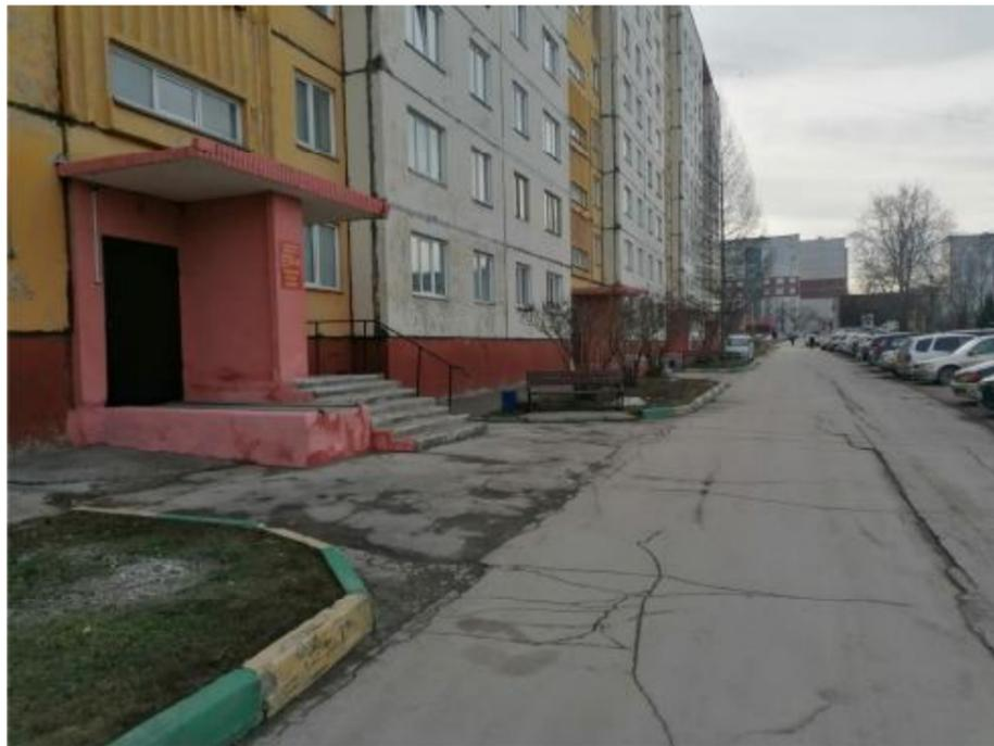
Подход к подъезду - разрушено а/б покрытие (имеются трещины, разрывы, разрушение, оголен нижний слой а/б) Скамейка и мусорная урна расположена на газоне
