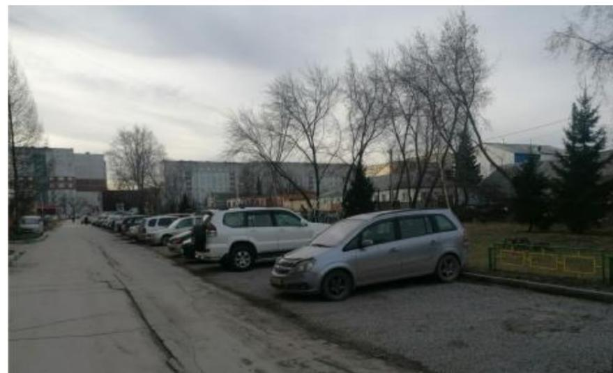
Дворовой проезд - разрушено а/б покрытие (имеется просадка, трещины, оголен нижний слой а/б,) Парковка выполнена в щебеночном покрытии.
