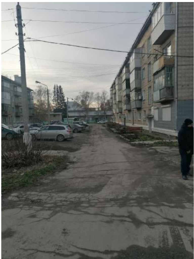
Из-за не хватки парковочных мест, газон используется не по назначению, газонное покрытие разрушено
