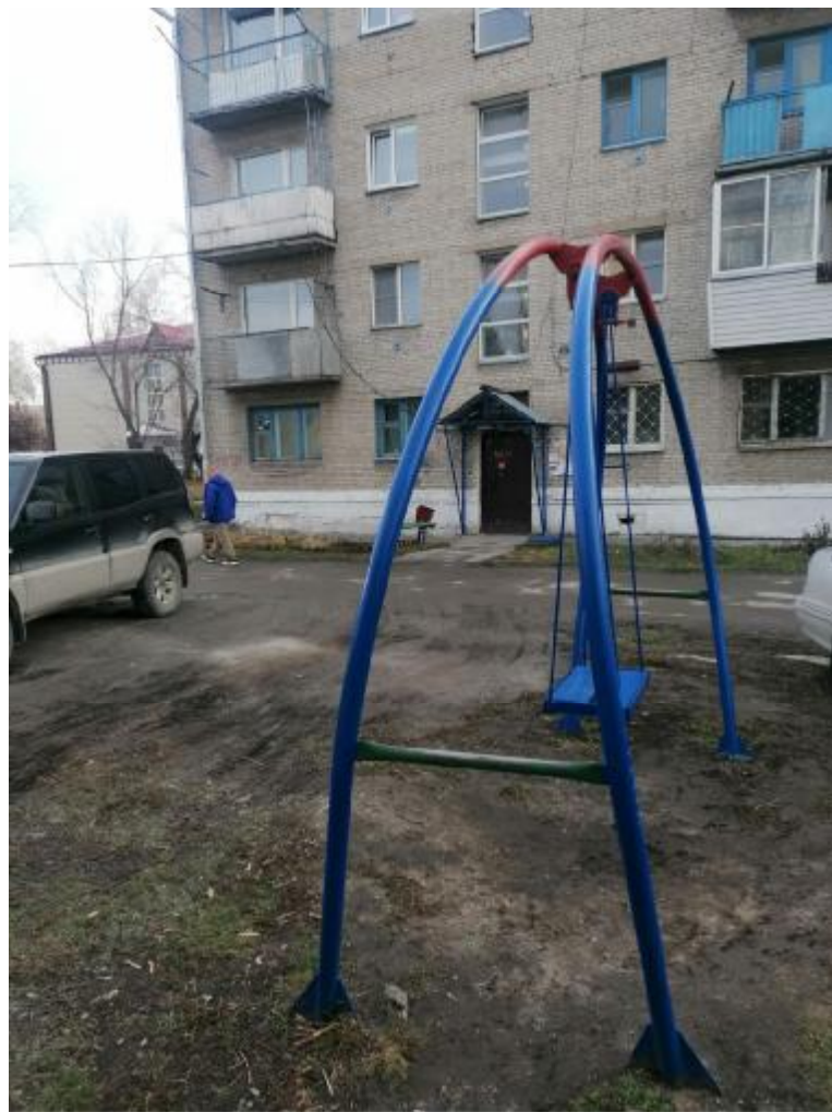
Устаревший детский игровой комплекс (облупилась краска, имеются острые углы в местах сварки элементов)
