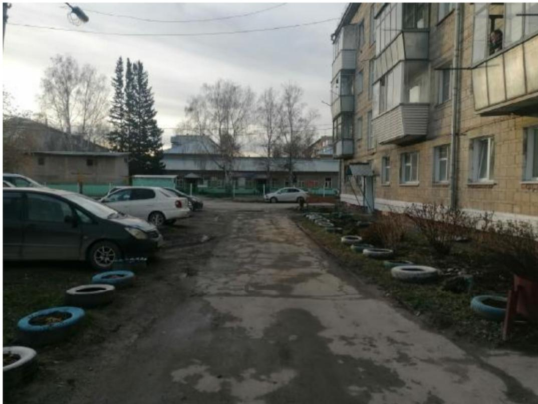
*Проезд разрушен, оголено основание, подход к подъездам разрушен.*
