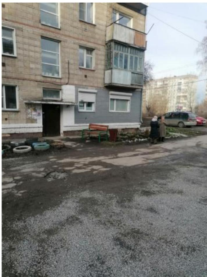
Подход к подъезду - разрушено а/б покрытие (имеются трещины, разрывы, разрушение, оголен нижний слой а/б)
